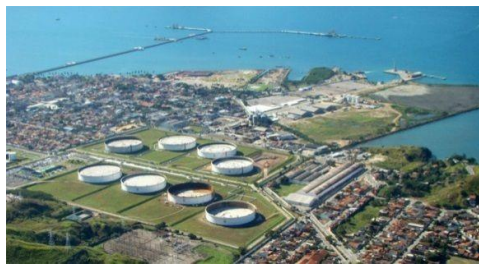
Figura 90 Vista aérea do espaço portuário de São Sebastião. Fonte: CDSS. Disponível em www.portossa.com .
